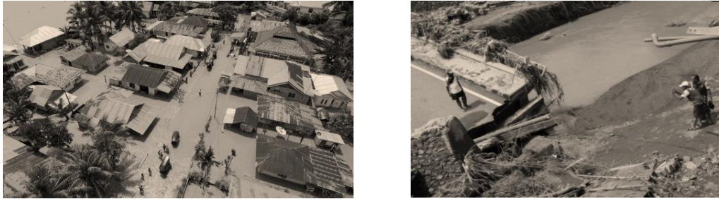
Gambar 1. Dokumentasi banjir Kota Bima akibat Sungai Pedolo tahun 2016
