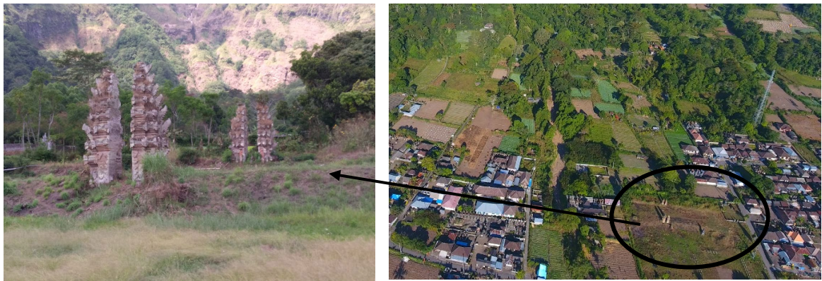
Gambar 4.7 Longsoran debris menutup Pura Tuluk Biyu dan keratan longsor
