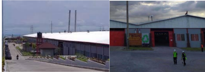
Gambar 4.2 Penampakan Cerobong Asap TPST Desa Kesiman Kertalangu
