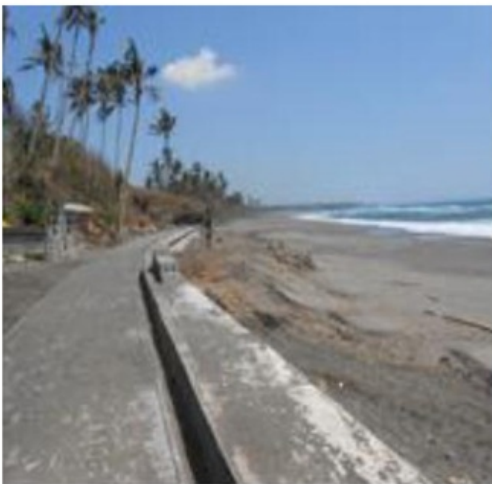
Gambar 5. Pemasangan Revetment dari Pasangan Batu Kali di Pantai Kedungu
