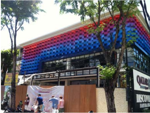
Gambar 3. Fasad Bangunan Fave Hotel Sumber: analisis, 2016
