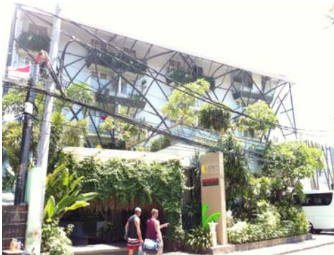
Gambar 2. Fasad Bangunan Eden Hotel Sumber: analisis, 2016
